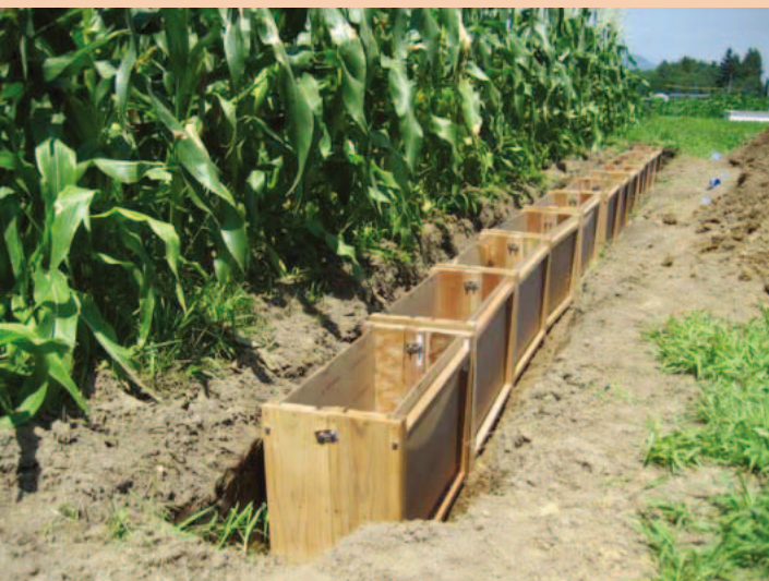
写真3 根箱を埋設した様子
