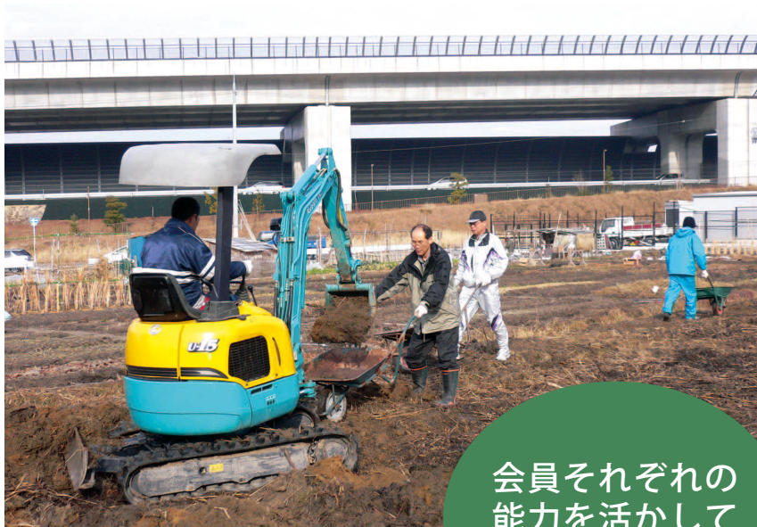
重機を使って長さ 100 m の溝掘り
