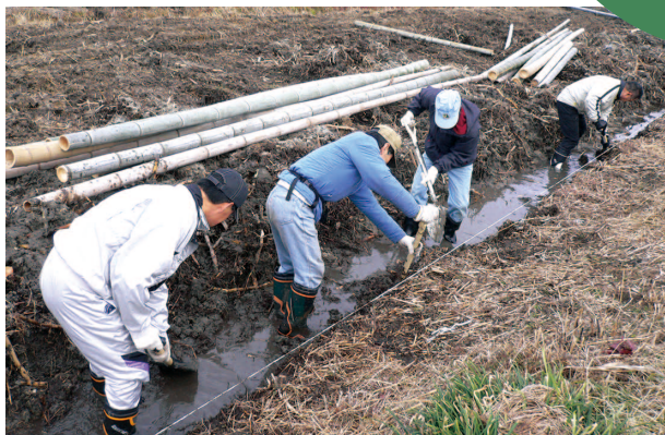
竹の土留めを利用して排水溝づくり
