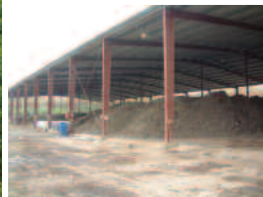
▲都市ゴミからEMを用いて堆肥を製造している工場(ハノイ市)
