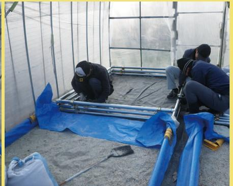
写真3 単管で枠を組んでブルーシートの舟を作り、洗い砂をいれる
