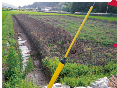
十分な育土と排水性を確保してからハウスを設置
